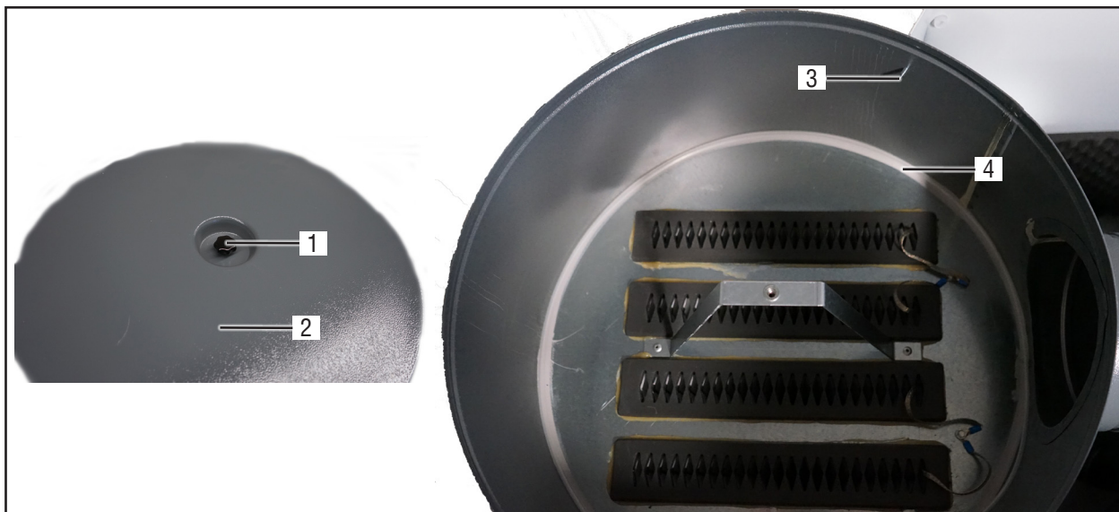
Afb. 13 Voorbereidende werkzaamheden voor de filterwissel
